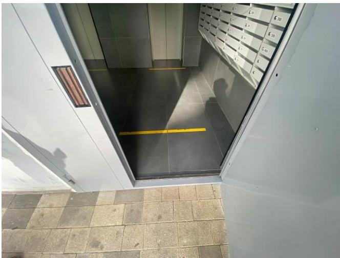
Фото 7. г. Краснодар, ул. им. генерала-лейтенанта Александра Сапунова, д. 13, кв. 325_Вход в подьезд
